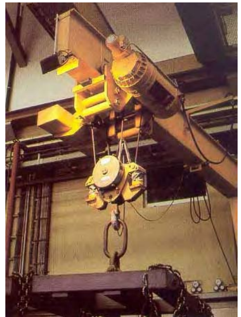
5-тонный весовой блок крюка с двумя датчиками веса на химическом предприятии
